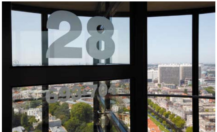
■ De stempel in het brandwerend glas is goed zichtbaar.
