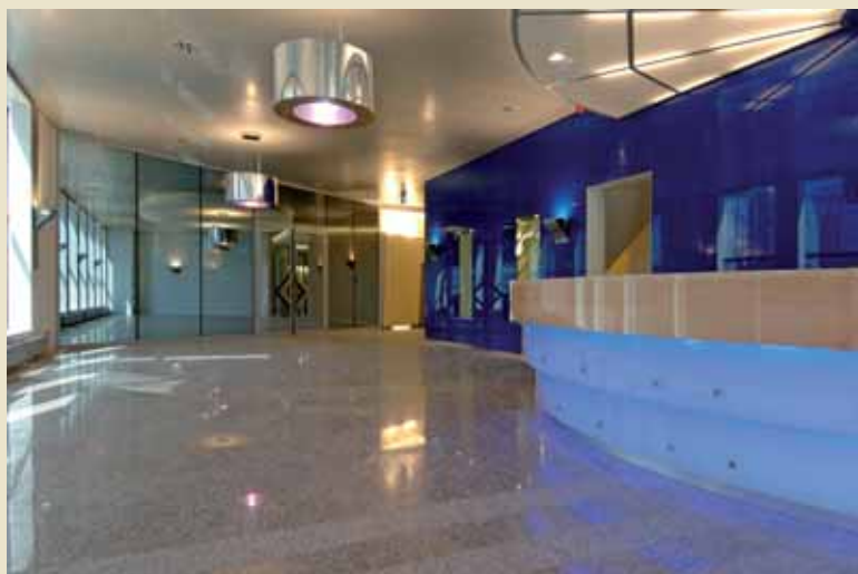
ING Centerpoint Amsterdam: brandwerend glas met een hoogte van 3.700 mm.
