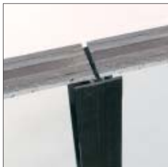
Vitrage avec joint profilé H
